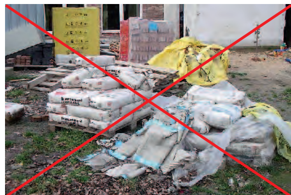
Bild 3.3-2: Mörtel (Sackware) nicht vor Beregnung geschützt
