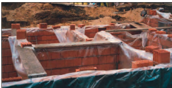
Bild 11-3: Abdeckung von Mauerkronen
