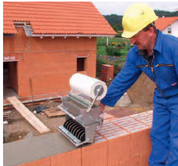
Bild 6.3-4: Mörtelauftrag aus Kasten mit Gewebe
