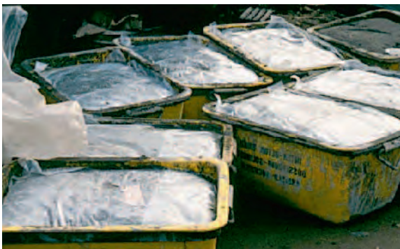
Bild 3.2-1: Mauermörtel (Sackware auf Palette) – Schutz vor Durchfeuchtung
