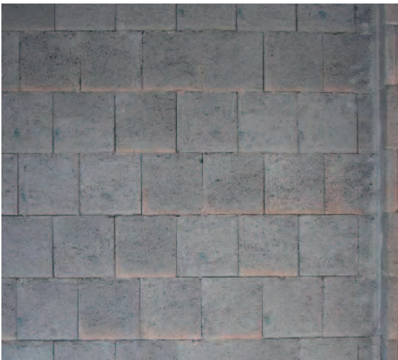
Bild 6.3-7: Sachgerechte Ausführung der Stoßfugen, Mauersteine knirsch verlegt (Steinhöhe h = 249\text{ mm} )
