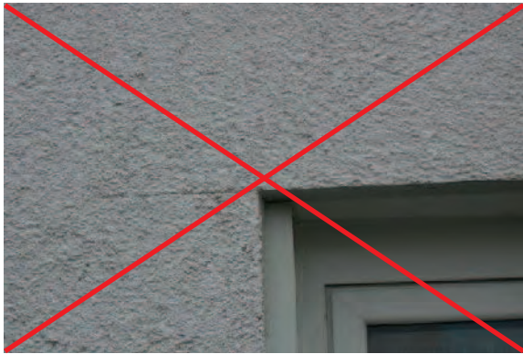
Bild 12.5-2: Riss am unteren Rand der Rolladenschürze, Putz nicht bewehrt
