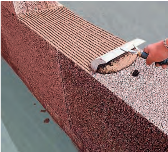
Bilder 6.3-1 und 6.3-2: Sachgerechter Mörtelauftrag mit Zahnkelle bzw. Mörtelschlitten
