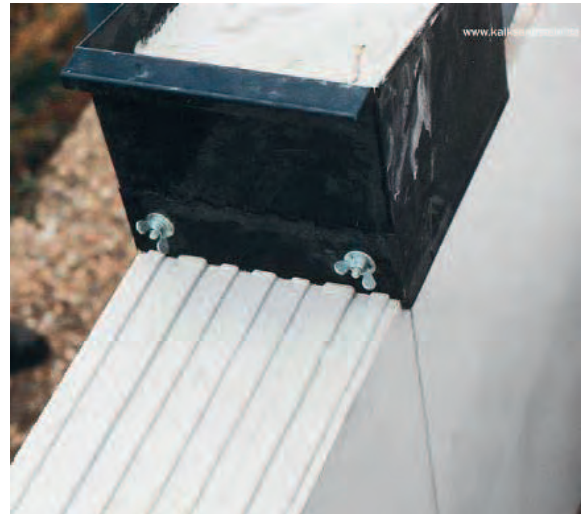
Bilder 6.3-1 und 6.3-2: Sachgerechter Mörtelauftrag mit Zahnkelle bzw. Mörtelschlitten
