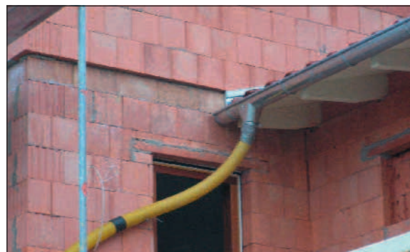
Bild 11-4: Unschädliches Abführen von Regenwasser
