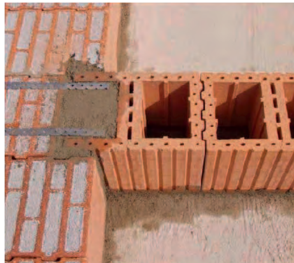
Bild 7-4: Schlitzverankerung
