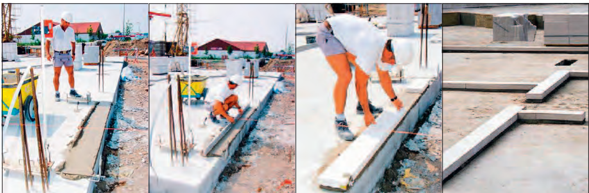
Bilder 6.2-1 bis 6.2-4: Ausführen der unteren Kimmsteinlage
