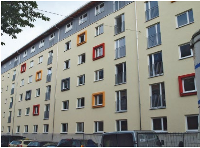
Bild 3. Mittels WDV's auf Basis von EPS-ummantelten VIP sanierte Fassade eines MFH in München Fig. 3. Restored façade of a multi-family house in Munich consisting of thermal composite insulation system with EPS covered VIP
