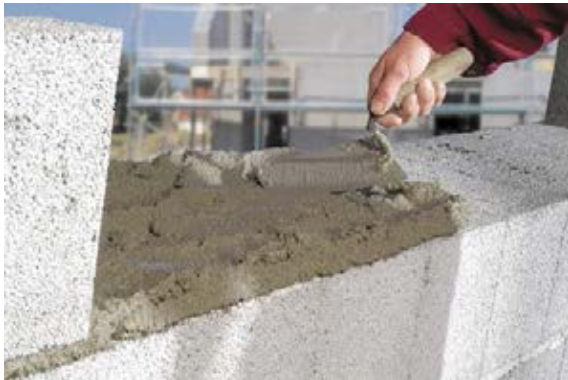
Abb. 14: Materialeinsparung und Ressourcenschonung durch weiterentwickelte Mauertechniken Normal- und Dünnbettmörtel weisen grundsätzlich eine sehr ähnliche stoffliche Zusammensetzung auf. Beim Dünnbettmörtel (DM) ist die Korngröße der Zuschläge allerdings auf 1 mm begrenzt. In punkto Nachhaltigkeit bzw. Ökologie wirkt sich zudem positiv aus, dass fugenwirksame Wärmebrücken erheblich reduziert werden.
