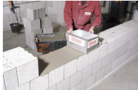
Abb. 14: Materialeinsparung und Ressourcenschonung durch weiterentwickelte Mauertechniken Normal- und Dünnbettmörtel weisen grundsätzlich eine sehr ähnliche stoffliche Zusammensetzung auf. Beim Dünnbettmörtel (DM) ist die Korngröße der Zuschläge allerdings auf 1 mm begrenzt. In punkto Nachhaltigkeit bzw. Ökologie wirkt sich zudem positiv aus, dass fugenwirksame Wärmebrücken erheblich reduziert werden.
