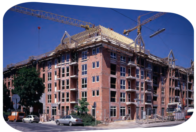
Bild 1 und 2: Homogenes Ziegelmauerwerk
