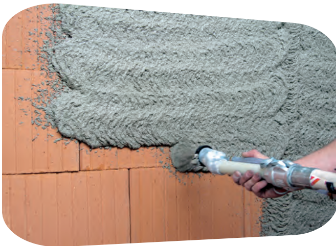
Bild 13: Auftrag des Unterputzes auf Planziegelmauerwerk
