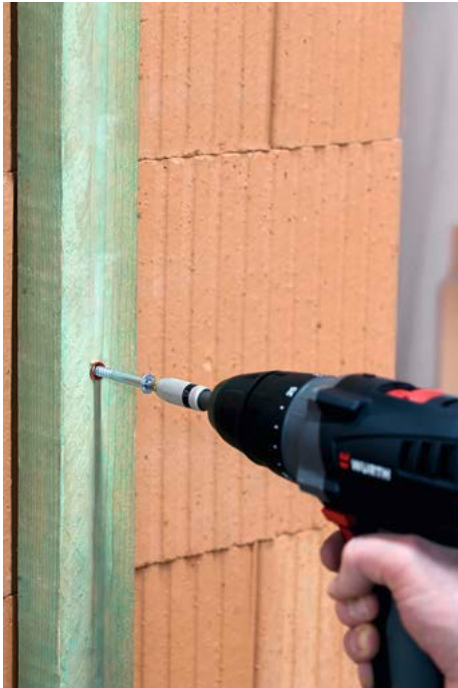
Bild 13. Kunststoff-Rahmendübel als a) Schraub- bzw. b) Nageldübel
