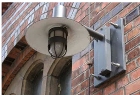
Bild 25. Befestigung mit vier Injektionsdübeln a) einer schweren Außenleuchte in einem Vollziegelmauerwerk und b) einer Halterung für einen schweren TFT Bildschirm
