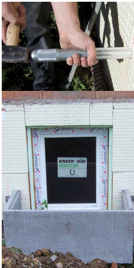
Bild 44. Montage eines Lichtschachtes mit dem System AMO®-Max
