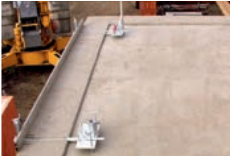
1. Anlegen des Mörtelbettes mit einer Justiereinrichtung
