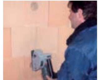
Schlitzten der Ziegel mit der Schlitzfräse.
