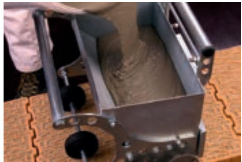
3. In honigartiger Konsistenz wird der frisch aufgerührte Dünnbettmörtel in das Auftragsgerät gegossen.
