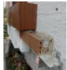
WDF auf wärmedämmtem Ziegelsturz und Stahlkonsole
