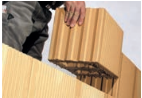
2. Mit Dünnbettmörtel benetzte Lagerfläche
