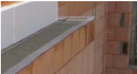
Lastfreistreifen ("Zentrierleiste") auf Bitumenbahn R 500
