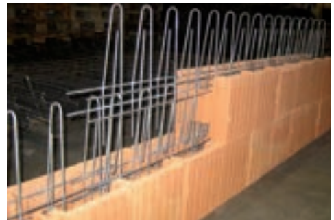
Horizontal und vertikal bewehrtes Planfüllziegelmauerwerk
