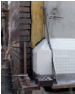
Klinker-Verblendschale mit Kerndämmung auf Edelstahlkonsole
