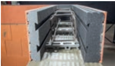
Ziegel-Wärmedämmschale mit bauseits eingebrachtem Bewehrungskorb auf Abstandhaltern vor dem Betoniervorgang..
