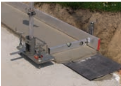
3. Kontrolle der waagrecht Lage des Mörtelbettes
