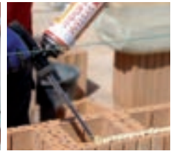
Auftrag Dryfix-Planziegelkleber
