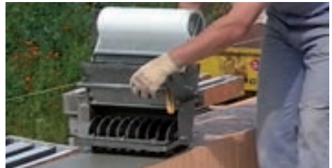
V.Plus: Glasfamentgewebe eingebettet in Dünnbettmörtel
