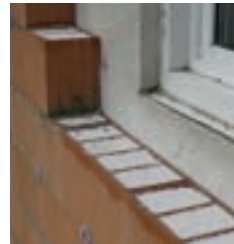
Fassadenanierung mit wärme- medämmenden WDF-Ziegeln
