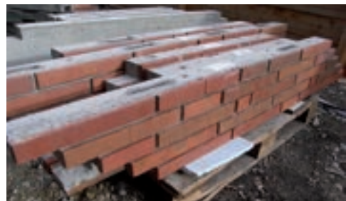
Klinker-Fertigteilstürze mit Ankerschienen für Aufhängung
