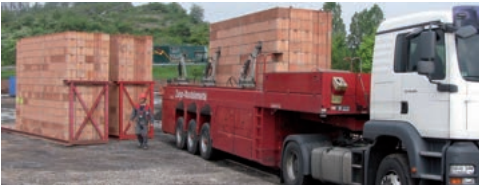
Anlieferung von gemörtelt vorgefertigten Mauertafeln (Transportsystem Vergusskanäle) auf Transportpaletten im Innenlader
