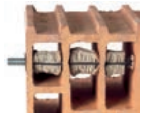
Injektionsdübel mit Gewindeanker
