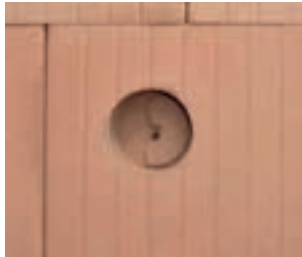
Ziegelreste und Bohrmehl entfernen.
