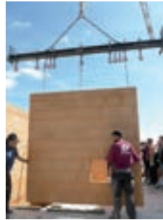
Montage Ziegelwand-Fertigteilelemente 2017 (KfW-EH-55)
