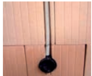
Einlegen der Elektroinstallation in die Schlitzte.
