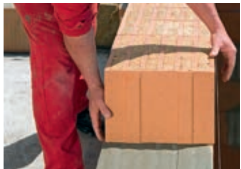
5. Planziegel werden in der Regel "knirsch" (unvermörtelte Stoßfuge, b \leq 5 \text{ mm} ) im frischen Dünnbettmörtel versetzt.
