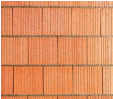
Blockziegelmauerwerk (Steinhöhe 238 mm, Lagerfuge 12 mm)
