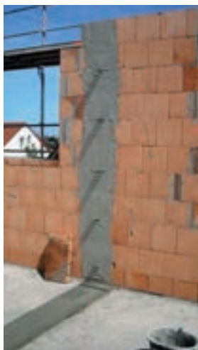
Bild 2: Anschluss Innenwand
