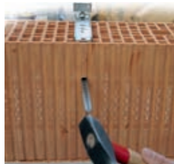
Bilder unten: Verankerung über Förch V-Lochschiene, die in eine Bohrung in der Brüstung eingeschlagen wird. Übliche Rahmenschrauben werden mit der V-Lochschiene von oben verschraubt.
