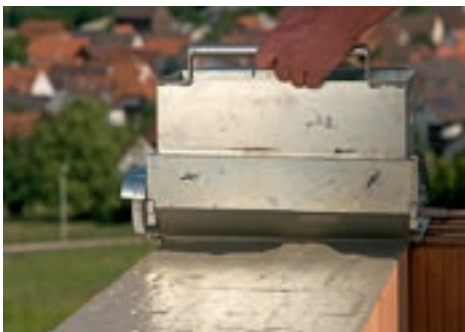
4. Durch gleichmäßiges Ziehen der Mörtelwalze (hier: VD-System) wird vollflächig deckelnde Lagerfuge erzeugt.
