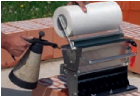
2. Vor dem Befüllen mit Dünnbettmörtel wird die Mörtelwalze (hier System V.Plus) mit einem Trennmittel benetzt.
