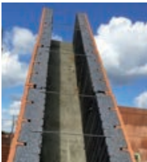
Variante der Ziegel-Wärmedämmschale mit oben liegenden Stahlhaltebügel
