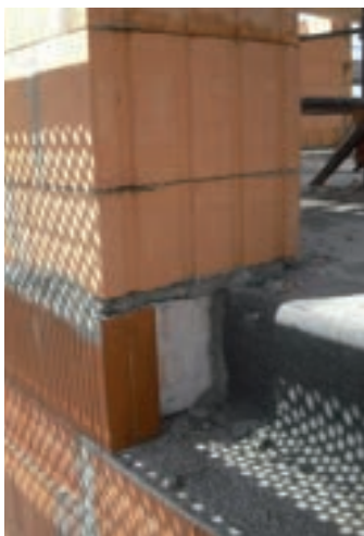
Bild 1: Deckeneinbindung/Balkontüröffnung
