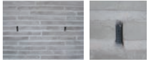
Lüftungs-/Entwässerungsöffnungen; Bild rechts: Gittereinsatz
