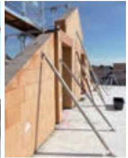
Montage Ziegelwand-Fertigteilelemente 2017 (KfW-EH-55)
