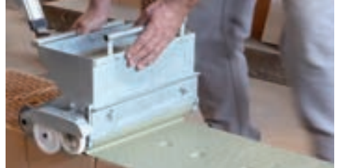
VD: Vollflächiges Dünnbettmörtelband auf Planhochlochziegel
