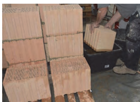
b) Befeuchten des zweiten Steins
