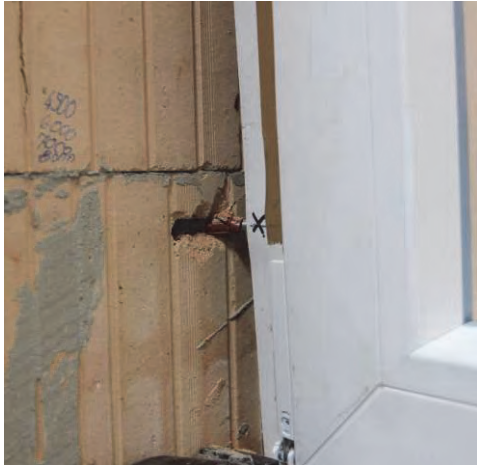
Abbildung 109 Langlochbildung am Befestigungspunkt über dem Riegel
