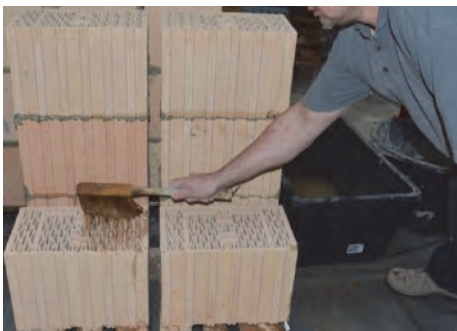
a) Befeuchten des ersten Steins
