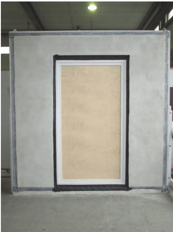
Abbildung 32 Fenstertüre in verputzte Wand eingebaut, Fuge abgedichtet
