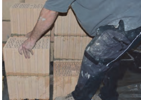
d) Setzen und Ausrichten des Steins
