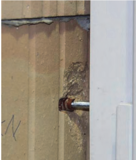
Abbildung 118 Langlochbildung am Befestigungspunkt über dem Riegel
