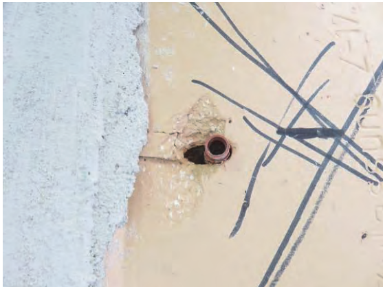
Abbildung 35 Befestigungspunkt 4 nach Ausbau des Fensterelementes
