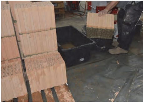
c) Tauchen des Steins in Dünnbettmörtel
