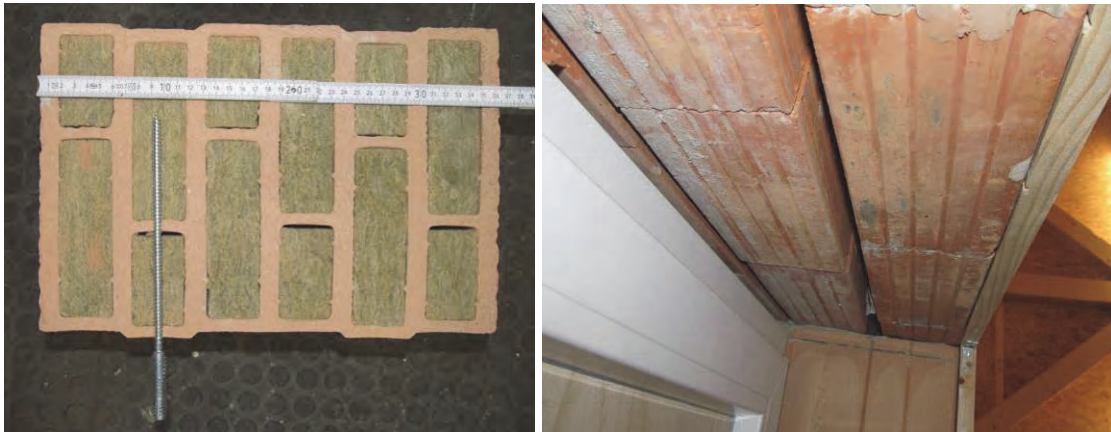
Abbildung 49 Links: Verwendeter Stein sowie Setzposition für den Bauteilversuch 3 Rechts: Sturzausbildung
